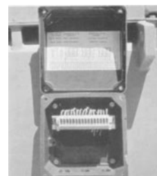
Slika 9 Priključna kutija termometara namotaja i ležaja
